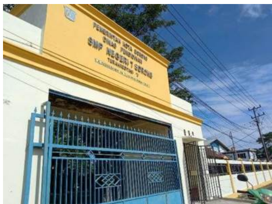
Gambar 1. Tampak depan Gedung SMP 07 Kota Sorong.
